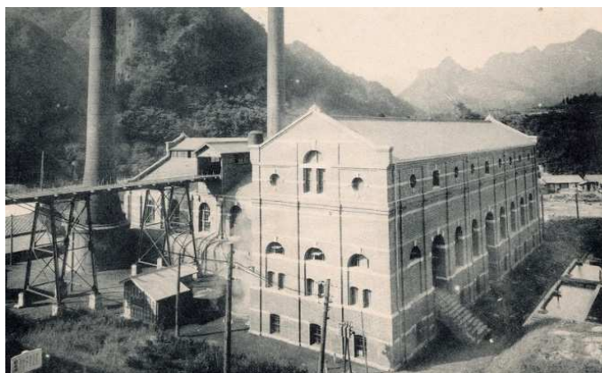
写真7 発電所の貯水池 ※発電所建屋の北側（画面右下）に長方形の貯水池と思われる物が写っている
