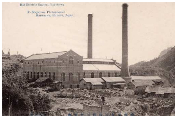
写真10 完成間近の発電所 ※画面中央下に遺構Cのみが見える。 この時点ではまだ遺構Dは存在していない
